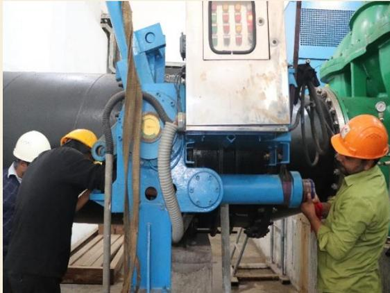
Figure 9. CW pump discharge valve এর hydraulic actuator এর সংরক্ষণ কাজ চলছে।
