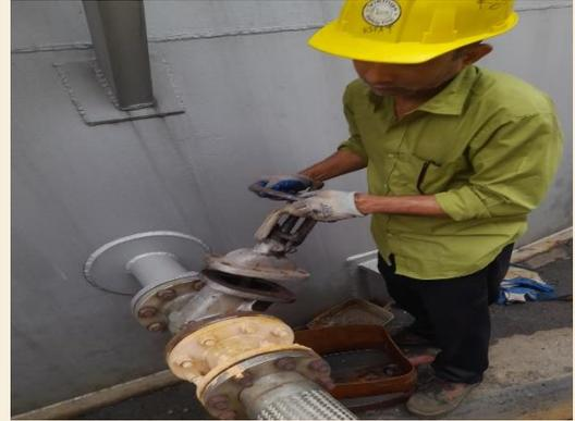
Figure 8. HSD Purifier to 5M storage tank-1 treated line manual valve এর passing এর সমস্যা সমাধান শেষে fitting এর কাজ চলছে।
