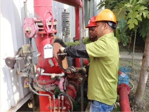
Figure 7. Firefighting water supply line এর একটি deluge valve এর passing rectification এর জন্য diaphragm এর internal condition checking এর কাজ চলছে।
