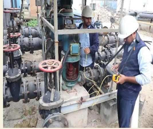
*Figure 2. Schedule Maintenance এর অংশ হিসেবে Raw water make up pump এর vibration measurement এর কাজ চলছে।*
