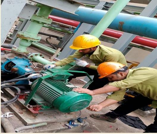
*Figure 1. Degassier pump এর alignment কার্যক্রম চলমান।*
