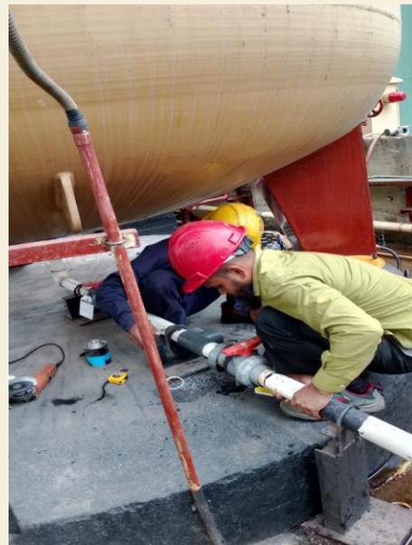
*Figure 4. Acid Storage tank এর transfer pump suction line modification এর কাজ চলছে।*
