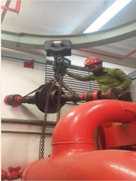
*Figure 3. Electric Firefighting pump এর Overhauling কার্যক্রম চলমান।*
