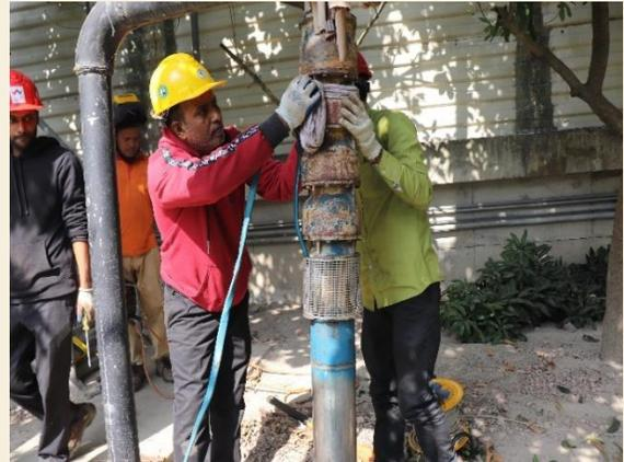
Figure 10. একটি submersible pump এর সংরক্ষণ কাজ পরবর্তী fitting এর কাজ চলছে।
