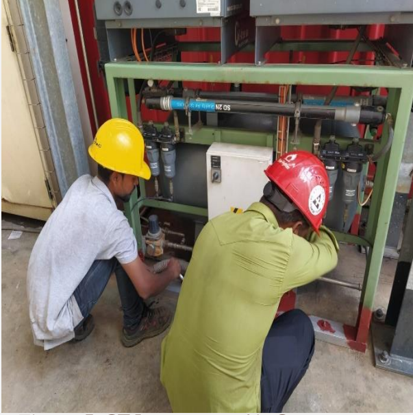
Figure 5. GT Instrument Air Compressor এর Schedule Maintenance এর কাজ।
