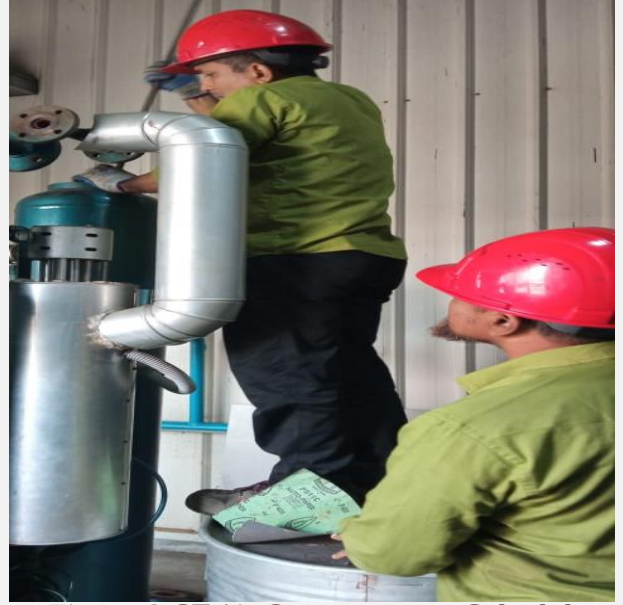
Figure 6. ST Air Compressor এর Schedule Maintenance এর কাজ।
