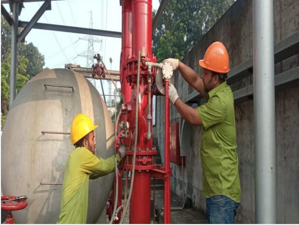
Figure 9. Fire Fighting Foam System এর Deluge Valve এর সংরক্ষণ কাজ।
