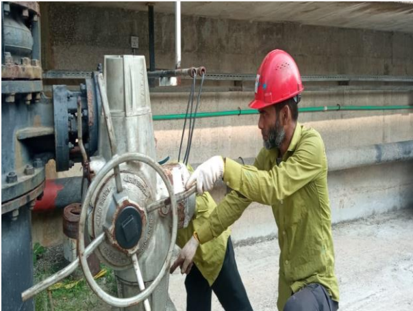
Figure 13. Cooling Tower water inlet valve MOV এর maintenance কার্যক্রম।
