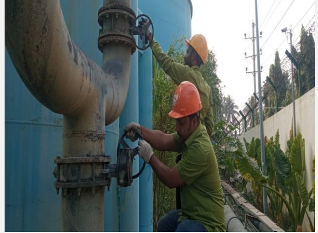
Figure 10. Sand Filter Intake valve এর Gearbox এর ত্রুটি মেরামতের কাজ।
