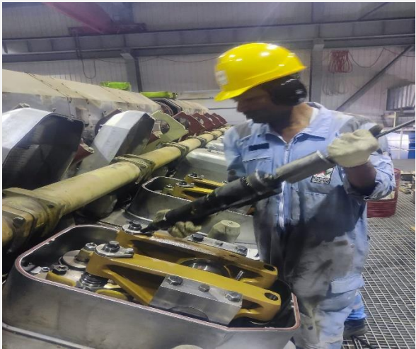
চিত্রঃ Fuel injection valve সিলিন্ডার থেকে তুলে pressure test করা হচ্ছে
