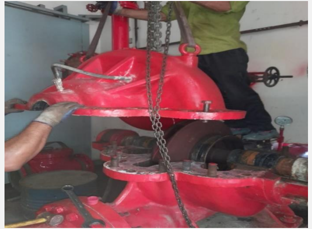
Figure 7,8. Diesel Driven Fire fighting pump এর Overhauling কার্যক্রম।
