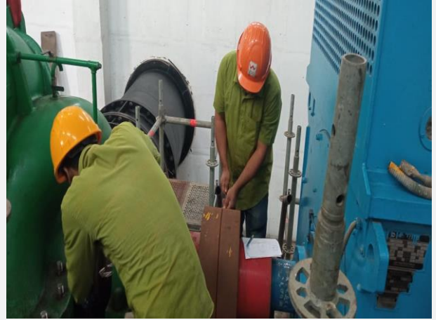
Figure 11,12. CW Pump এর Overhauling কার্যক্রম।
