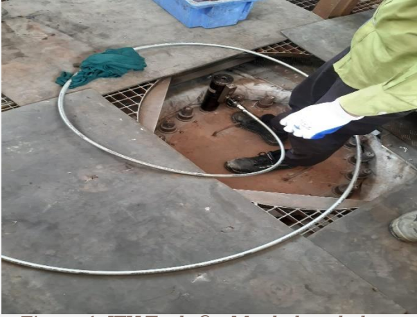
Figure 1. ITH Tools দিয়ে Manhole এর bolt খোলা হচ্ছে।
