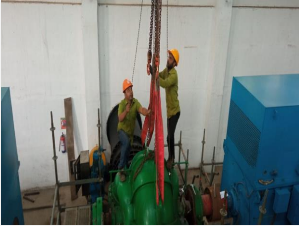
Figure 11,12. CW Pump এর Overhauling কার্যক্রম।
