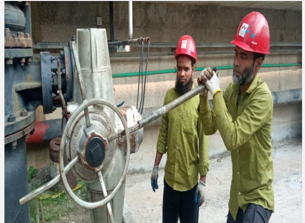
Figure 13. Cooling Tower water inlet valve MOV এর maintenance কার্যক্রম।
