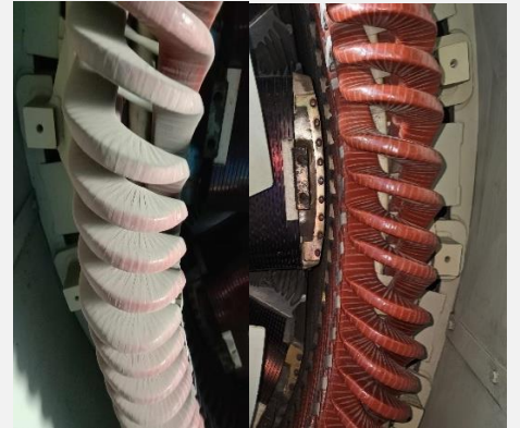
চিত্রঃ Stator Winding Cleaning এর পূর্বে ও পরে
