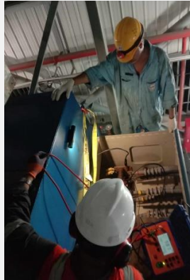
চিত্রঃ Alternator Stator Winding এর Insulation Resistance পরিমাপ কার্যক্রম
