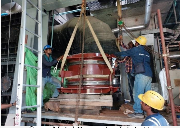
চিত্র ২.১: Metal Expansion Joint স্থাপন
