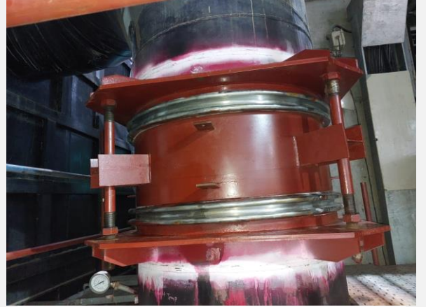
চিত্র ২.২: Metal Expansion Joint-এর NDT সম্পাদন
