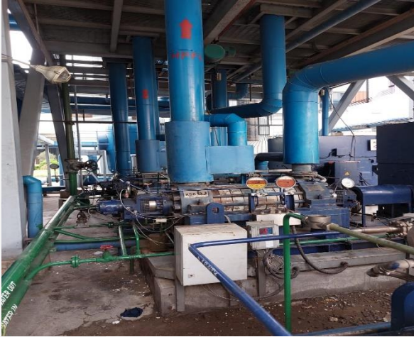
চিত্র ২.৩: বয়লার Feed Pump
