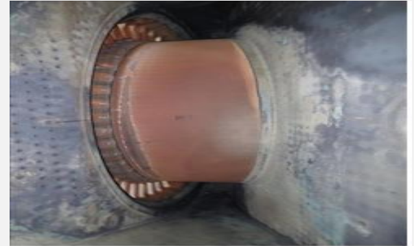
চিত্র ১.৪: Inner casing inspection
