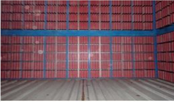
চিত্র ১.৩: Filter House inspection
