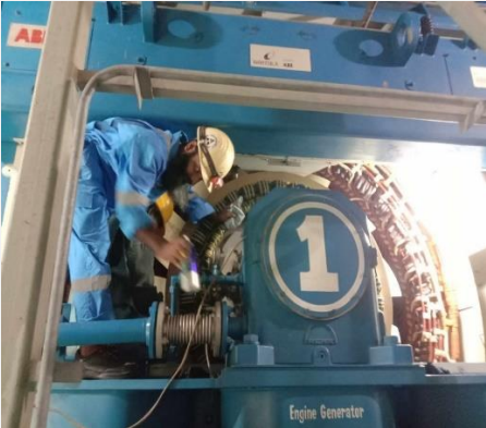
চিত্রঃ Excitation system এর diode bridge এর Visual Inspection কার্যক্রম
