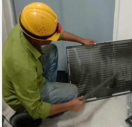
চিত্রঃ Air Intake Filter Cleaning এর পূর্বে ও পরে
