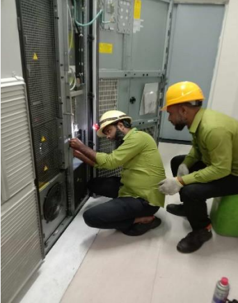
চিত্রঃ Radiator VFD এর Heat Sink খোলার মুহূর্তে
