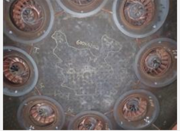
চিত্র ১.২: Burner Inspection
