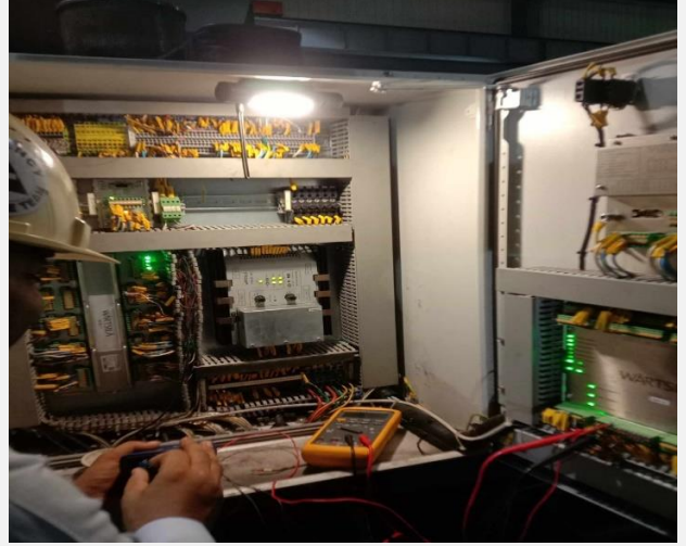
চিত্রঃ Engine এর Overspeed Trip Check করা হচ্ছে
