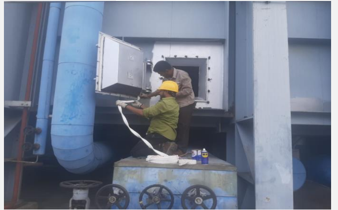
চিত্র ২.১০: Manhole-এ Gasket স্থাপন
