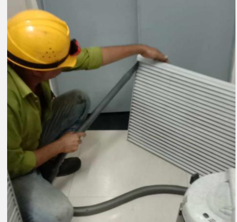
চিত্রঃ Air Intake Filter Cleaning এর পূর্বে ও পরে
