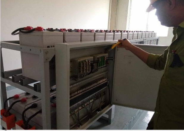
চিত্রঃ Battery System এর Terminal Box Clean করা হচ্ছে
