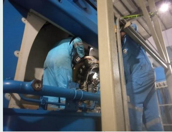
বিদ্যুৎ কেন্দ্রের Alternator এর দিবার্ষিক Schedule Maintenance কার্যক্রম এর আওতায় Stator ও Rotor coil, Cooling system, Neutral Grounding Resistor (NGR) Panel এর visual inspection ও cleaning করা হয়। Air gap ও winding insulation resistance পরিমাপ করা হয়। Excitation system এর diode bridge, Automatic Voltage Regulator (AVR) unit, Permanent Magnet Generator (PMG) এর visual inspection ও cleaning করা হয়।
