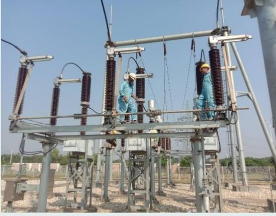
বিদ্যুৎ কেন্দ্রের এর বার্ষিক Schedule Maintenance কার্যক্রম এর আওতায় সকল Main Transformer, Circuit Breaker, Current Transformer (PT), Potential Transformer (PT) ও Surge Arrester এর Bolt Tightness Checking ও Insulator Cleaning করা হয়।
