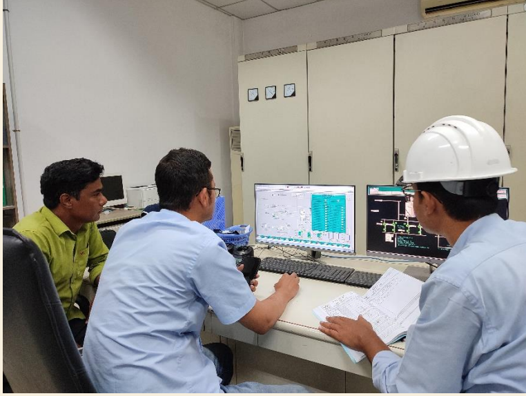
চিত্র-৪: Water Supply System সংক্রান্ত ডাটাসমূহ WTP কন্ট্রোল রুম থেকে মনিটর, অপারেশন ও কন্ট্রোল করার ব্যবস্থাকরণ কাজের খন্ডচিত্র।
