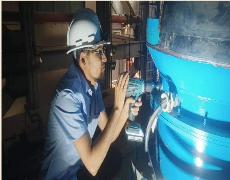
চিত্র-৫: GTG-তে Partial Discharge Analyzer স্থাপন।
