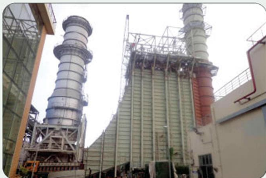
HRSG & Stack Upgradation of Khulna 150 MW PPP to 225 MW CCPP Project
