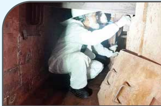
Inspection of HRSG by ED (Engg.), NWPGL
